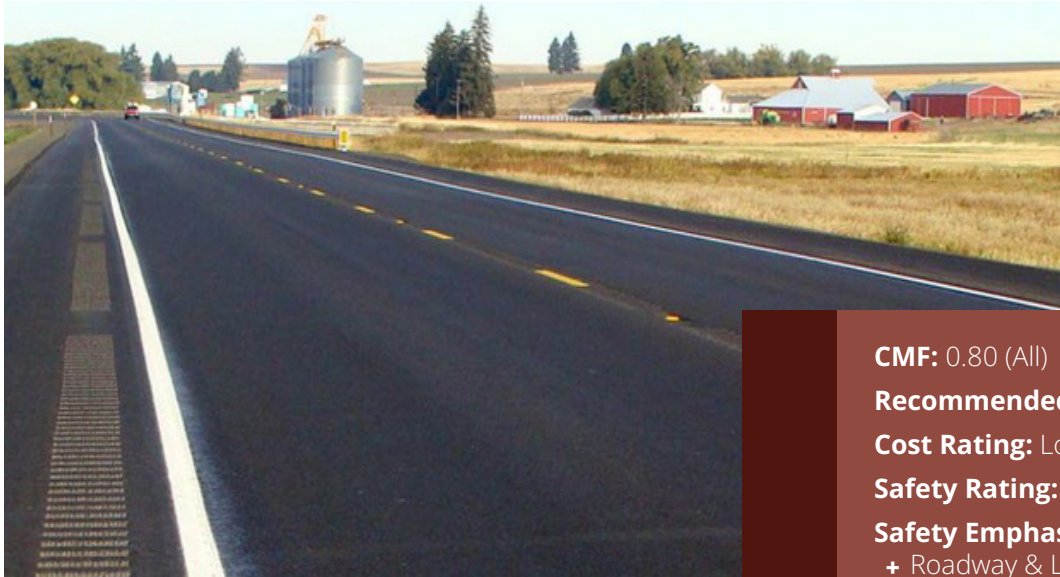
Figure 24 Longitudinal Rumble Strips
